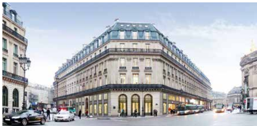
© Baptiste Lobjoy - rénovation Immeuble Meyerbeer LAFI MANAGEMENT - BBC-Effinergie Rénovation
